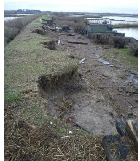
Figure 13 : Dépolderisation en cours du bras de preyrat (Ile de Malprat)
